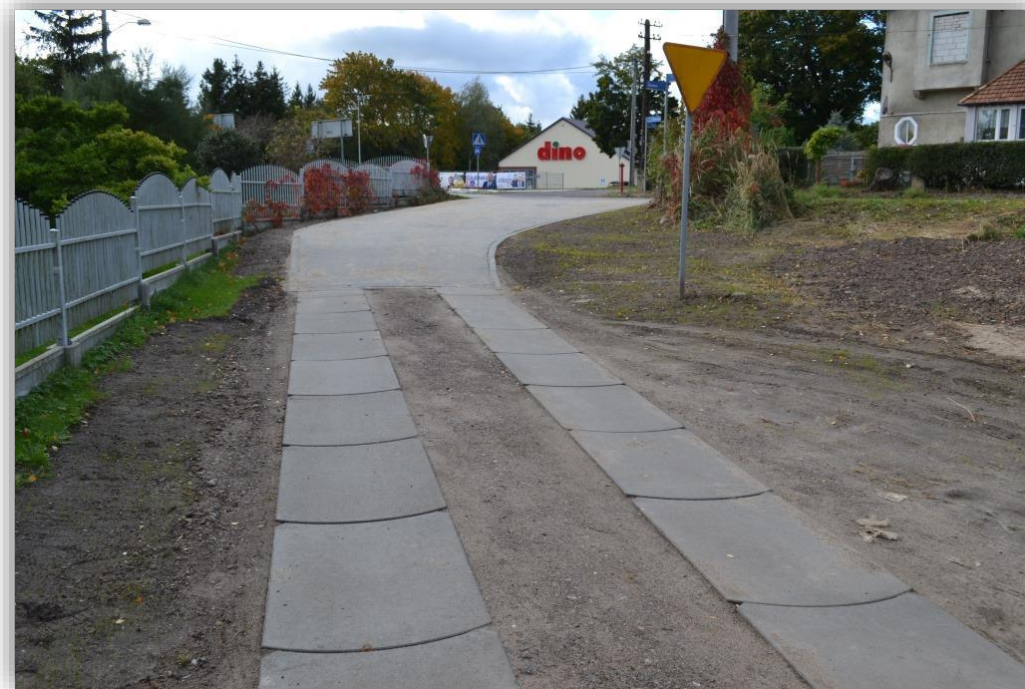
Przebudowa ulicy Ogrodowej w Starym Czarnowie
