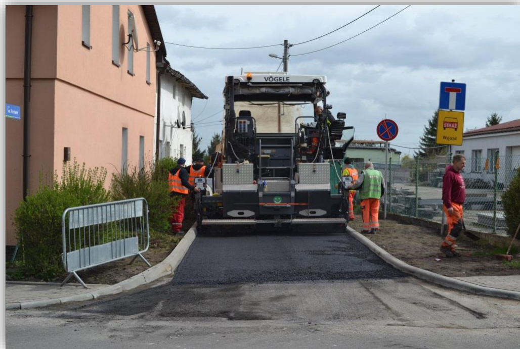
Remont ulicy Św. Floriana w Starym Czarnowie
