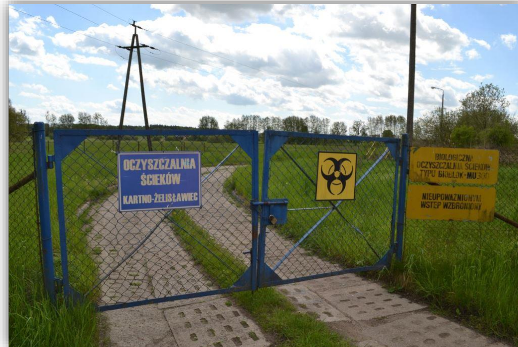
Budowa grupowego systemu kanalizacyjnego na terenie gminy Stare Czarnowo
