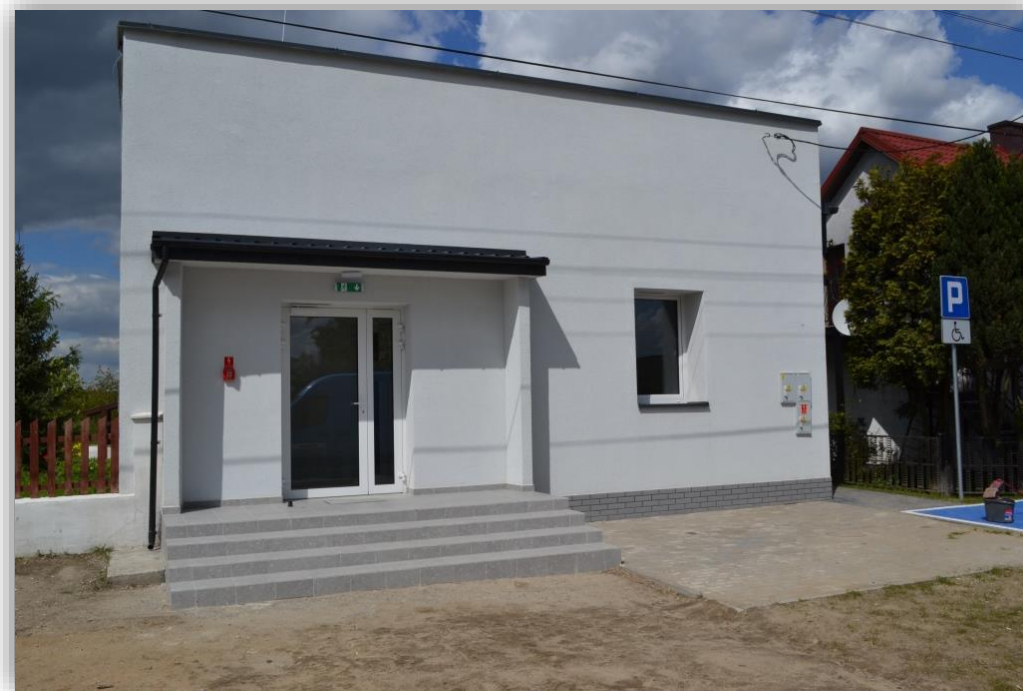
Przebudowa świetlicy wiejskiej w Dobropolu Gryfińskim
