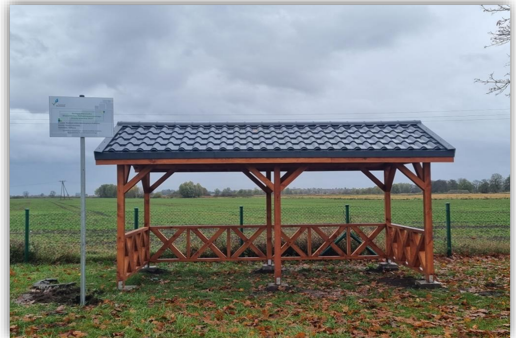
Budowa wiaty rekreacyjnej w Kołbaczu w ramach dotacji o wartości 15 tys. zł z programu „Granty sołeckie”
